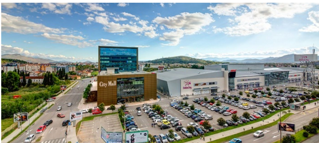
Slika 2.2. Izgled objekta na kojem se implementira projekat
