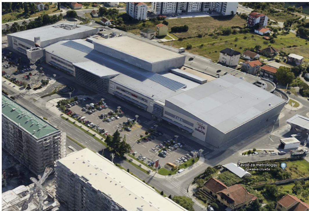
Slika 2.2. Izgled objekta na kojem se implementira projekat
