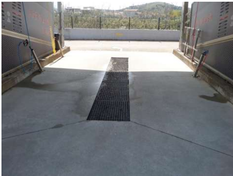
Slika 6. Izgled zasebnog boksa za pranje automobila
