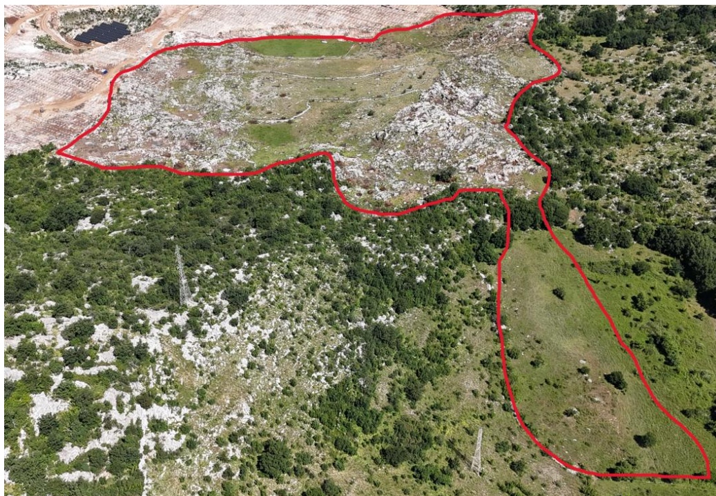
Slika 3. Izgled predmetne lokacije (snimci iz drona)
