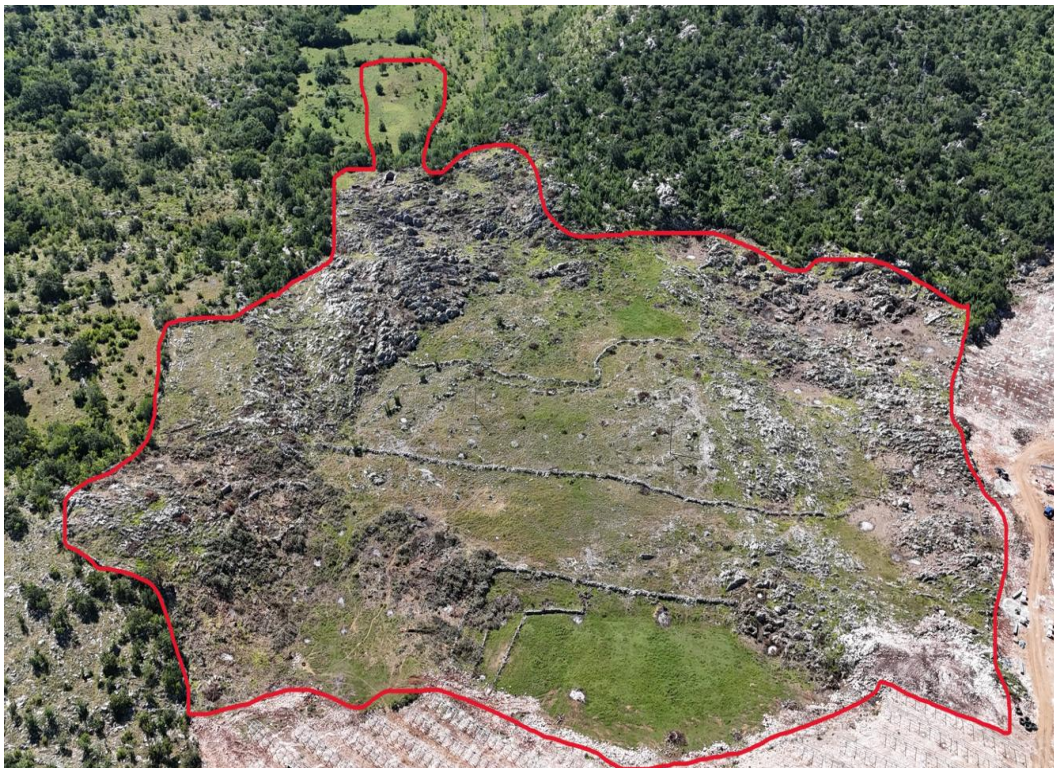
Slika 2. Izgled predmetne lokacije (snimci iz drona)
