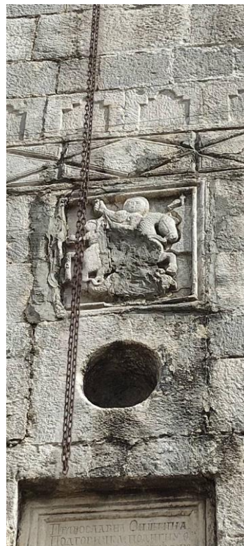
Oštećenje ulaznog kamenog portala
